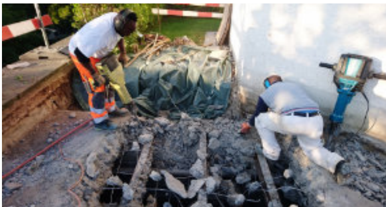
Der Geräteraum in der alten Friedhofsmauer wird renoviert.
